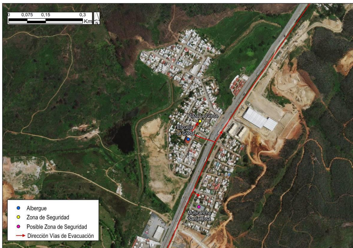
Figura 68. Localización zona de seguridad y albergues, sector de La Greda.
